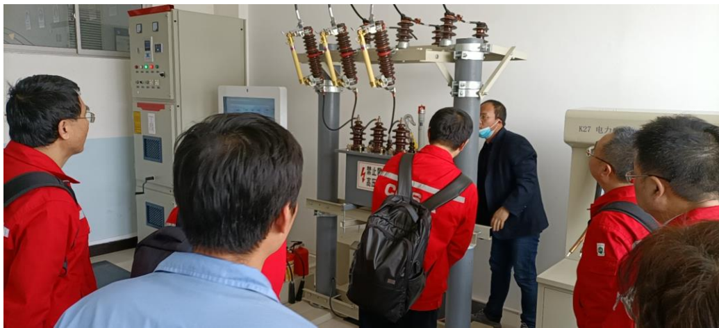
图为检查组一行参观高压电工仿真实训设备
